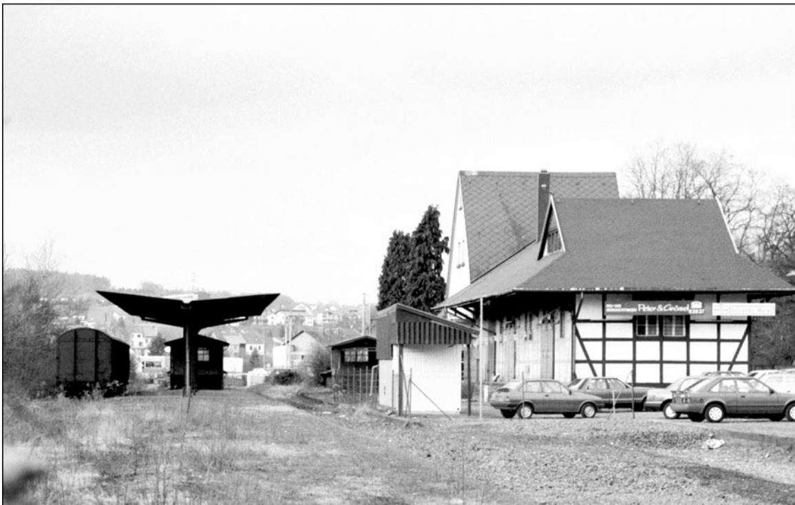
BAHNHOF PÜTTLINGEN, TEILWEISE DEMONTIERT & DEMOLIERT
