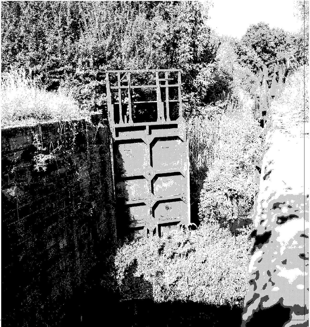
»DIE SCHLEUSENTORE KLAFFEN, WASSER RIESELT LANGSAM DURCH EIN FEUCHTBIOTOP.« - FOTO: K. BEHRINGER
