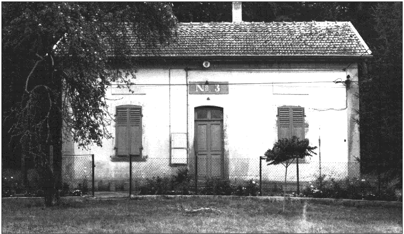
SAARKOHLLENKANAL, SCHLEUSENHAUS 3 - FOTO: K. BEHRINGER
